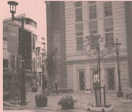
下町会館。昔の建物をそのまま生かした集会所で、下町地区のシンボル。総事業費は1億7千万。
